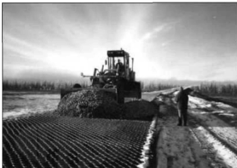
Rys. 9. Podbudowa nawierzchni drogowej wykonana przy użyciu geosiatki komórkowej a) Przekrój poprzeczny konstrukcji podbudowy lub nawierzchni
