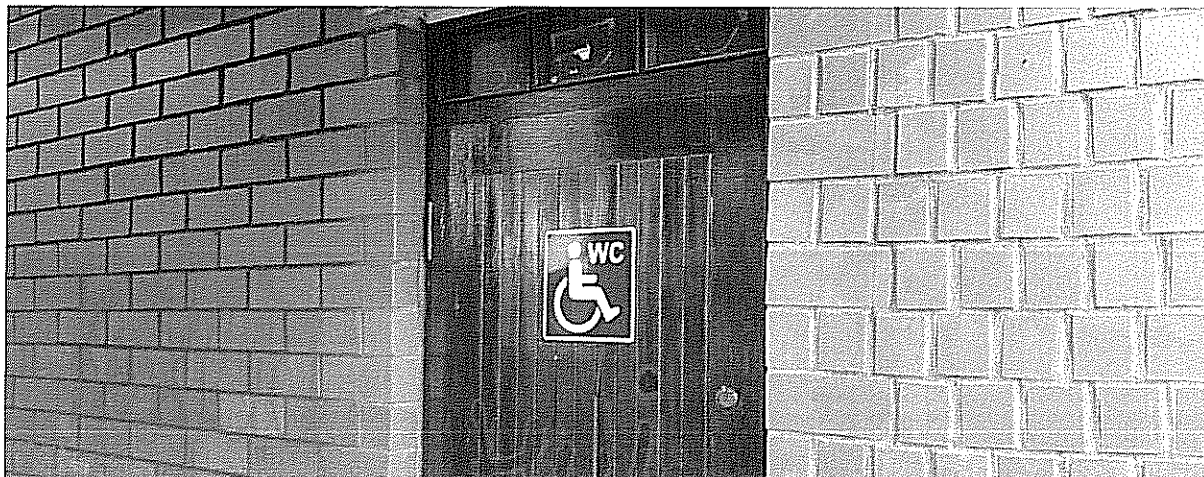
Zdjęcie nr 17. Wejście do toalety dla osób z niepełnosprawnościami
