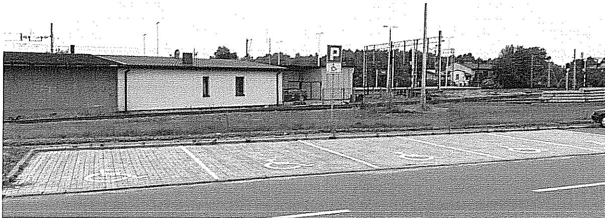
Zdjęcie nr 10. Widok na 5 stanowisk dla osób niepełnosprawnych o ograniczonej sprawności ruchowej oraz kierujących pojazdem przewożącemu taką osobę
