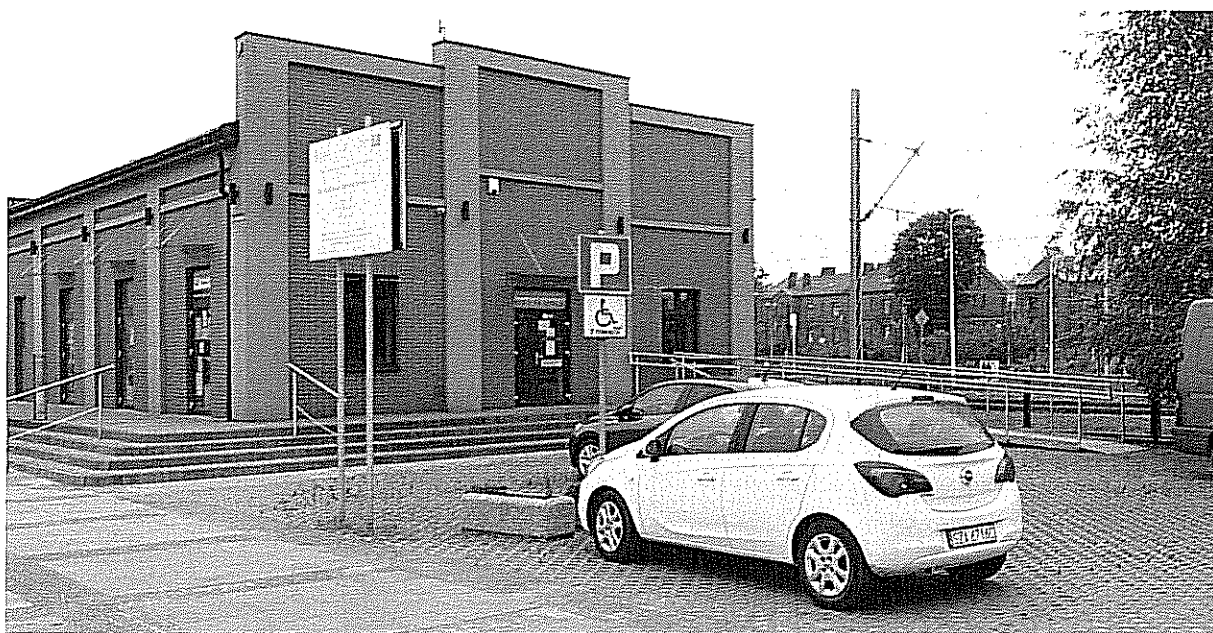
Zdjęcie nr 7. Widok na budynek dworca, rampę oraz chodnik od strony północno-wschodniej
