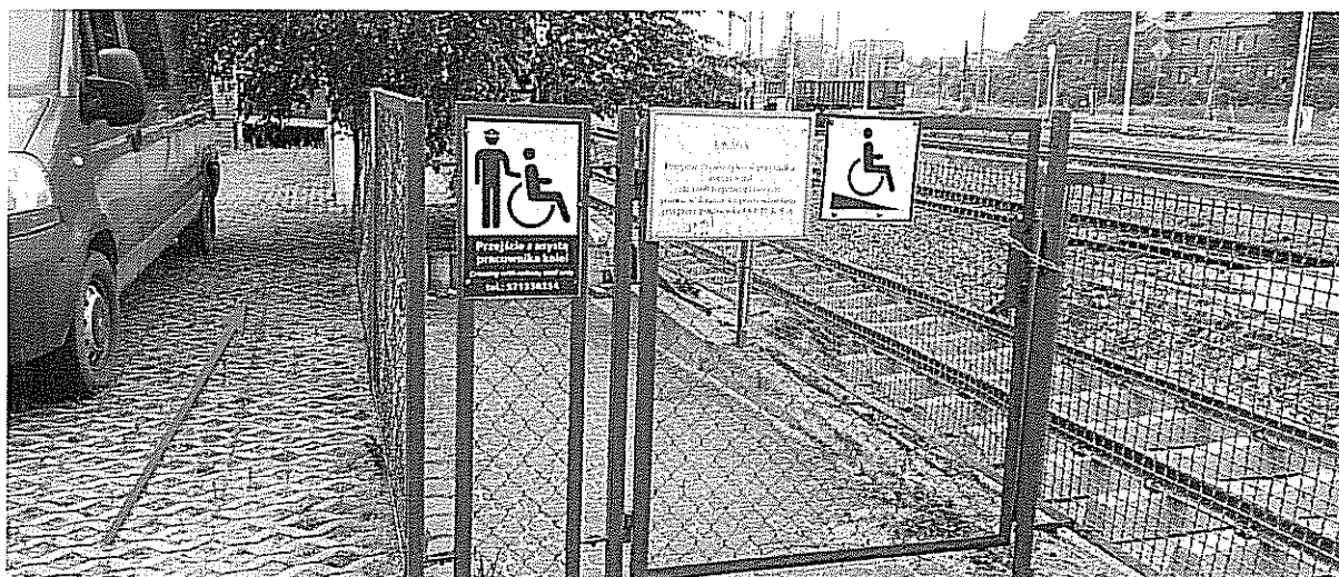
Zdjęcie nr 13. Widok na furtkę prowadzącą do przejścia na perony w poziomie szyn oraz płyty ażurowe prowadzące do rampy
