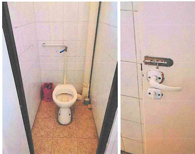
4. Luźny wieszak na papier w kabynie nr 3, ubytki w płytkach i fugach..
