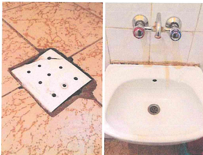
6. Pęknięty i zapadnięty odpływ oraz stan umywalki i kranu.
